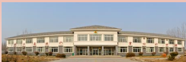
新教学楼正面全景
